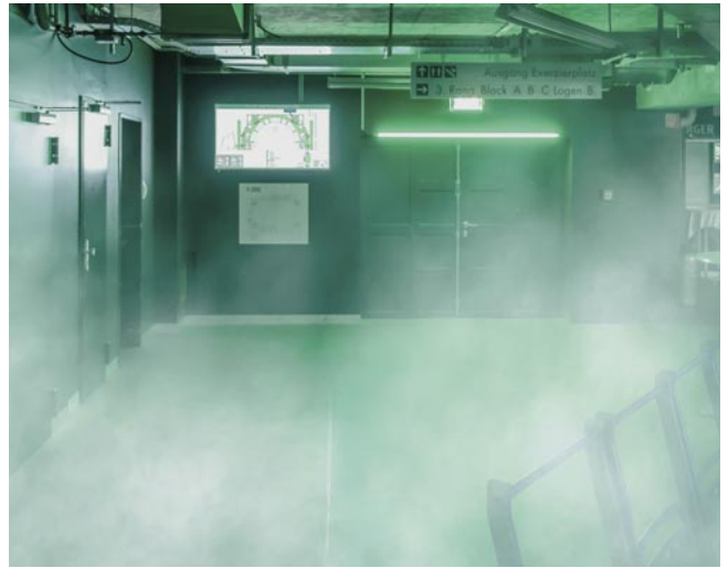
Probealarm in der Wunderino Arena: Die grünen Resqhalos zeigen die sicheren Ausgänge, während gesperrte Ausgänge Rot leuchten. Rechts: Das Resqhalo signalisiert deutlich den sicheren Fluchtweg in Grün, auf dem Screen erscheint der aktuelle Flucht- und Rettungsplan.
